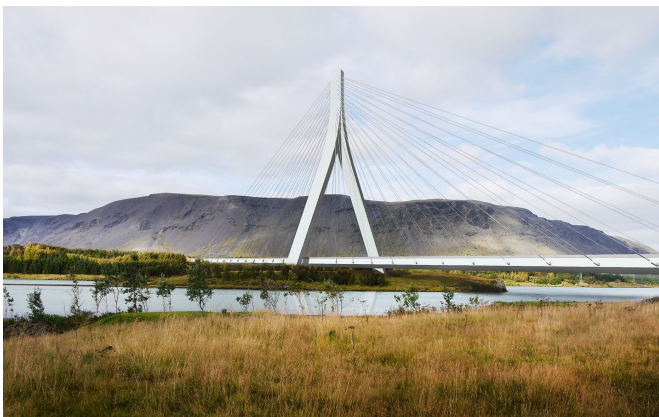
Ný brú yfir Ölfusá
