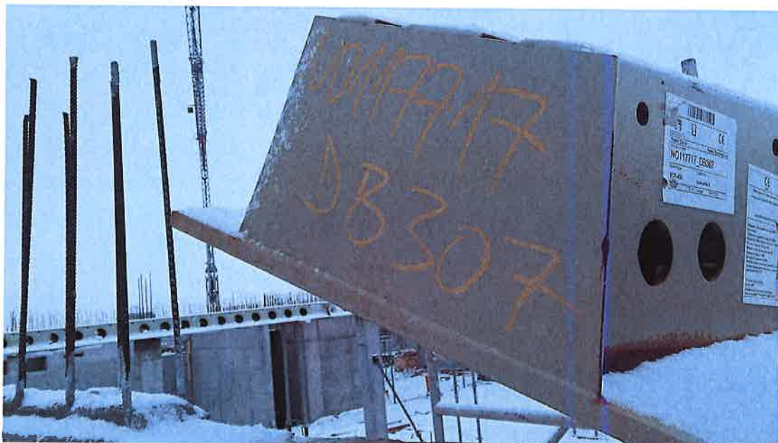
Mynd nr. 18: DELTABEAMS stálbitinn ekki festur á útvegg þar slysið varð.
