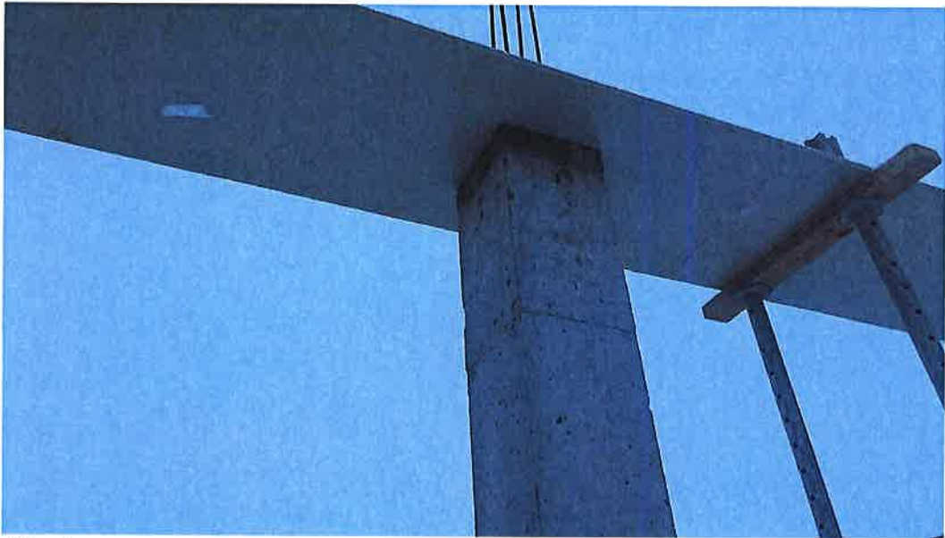
Mynd nr. 8: Steipt ofan á súlu í 5.röð til að leiðrétta hæð hennar. Steypa dekkri uppi við stálbita.
