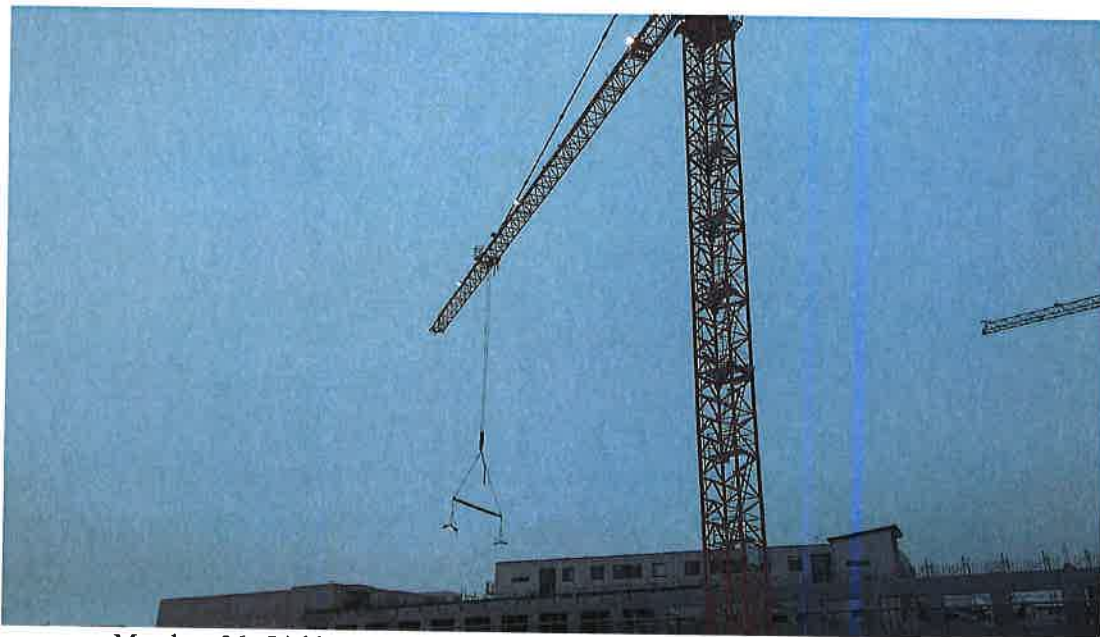
Mynd nr. 26: Liebherr 280 EC-H 16 og herðatré sem notuð voru til hífa holplötur.
