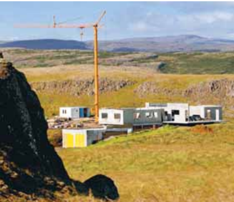
FRAMKVÆMDIR VIÐ SUMARHÚSIÐ Miklar framkvæmdir standa nú yfir á Veðilæk í Borgarfirði þar sem Sigurður Einarsson byggir.
