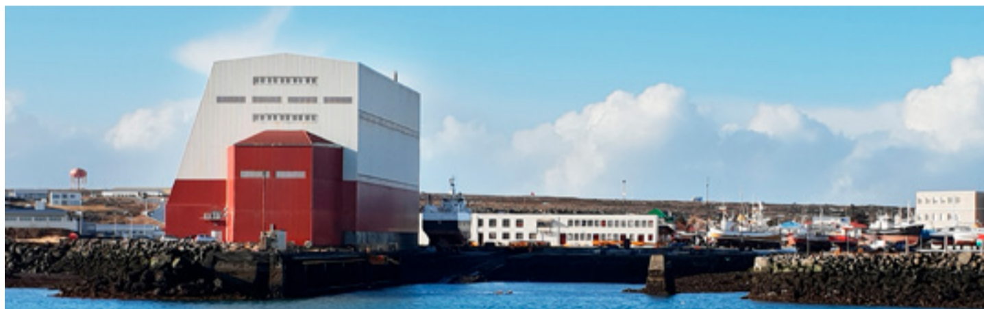
■ Skipasmíðastöð Njarðvíkur. Þar er áætlað að reisa þurrkvi.
