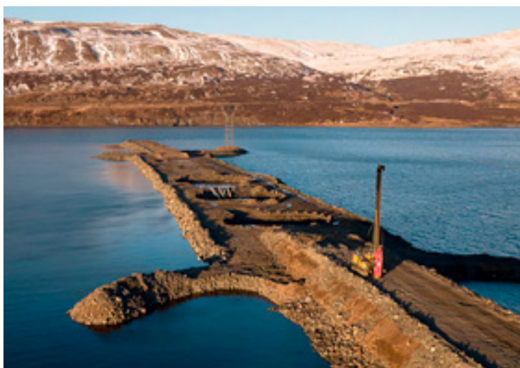
■ Framkvæmdir standa nú yfir við þverun þorskafjarðar.
