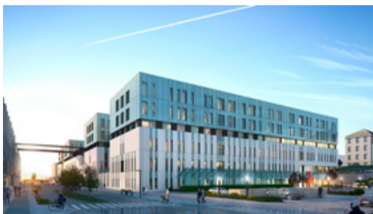
■ NLSH gera ráð fyrir að framkvæma fyrir um 10,5 milljarða á þessu ári sem er aukning um rúma 7 milljarða á milli ára. Megináhersla er á uppsteypu meðferðarkjarnans.
