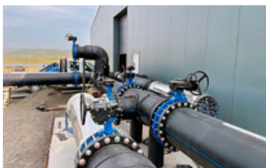
■ Vatnshreinsikerfi í stórseiðastöð Rifóss á Kópaskeri. Geislunargeta: 980l/s
