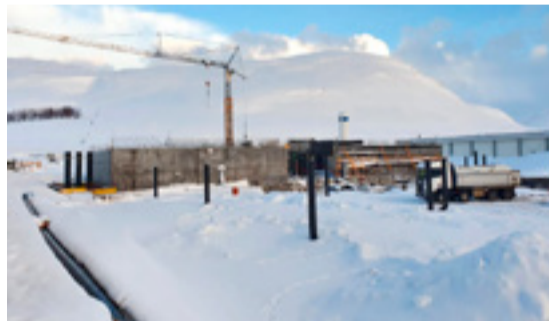
■ Byggingarframkvæmdir að vetri á Vestfjörðum eru eilíf glíma við veðurguðina.
