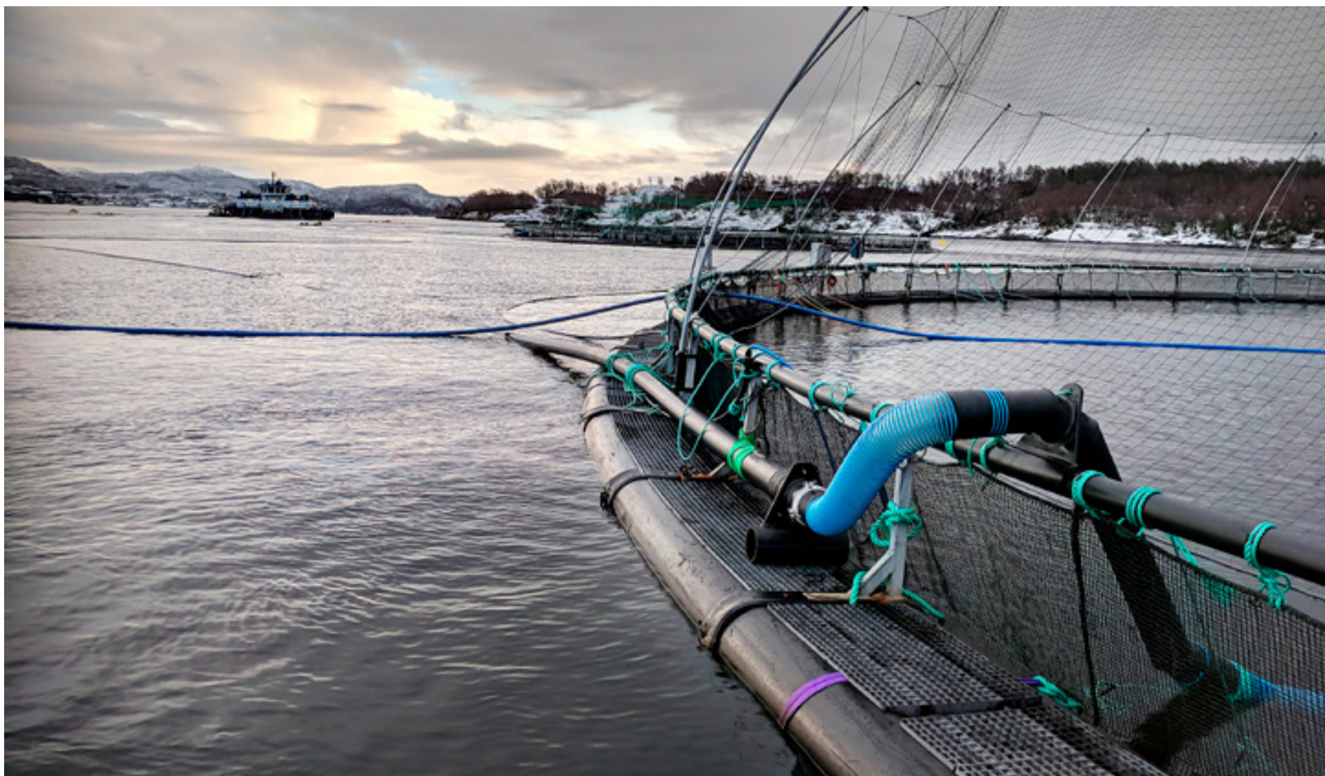
■ Lagnir liggja frá kvíunum að fóðurpramma. Kerfið er drifið áfram með loftþrýstingi.
