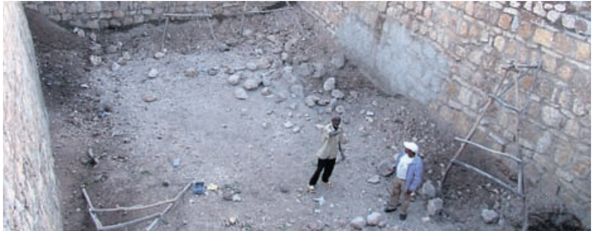
Vatnsþró í vinnslu í Eþíópíu. Heimamenn mynda vinnuflokka sem grafa þróna og steypa vegg og botn með fjárhagsaðstoð verkefnisins.
