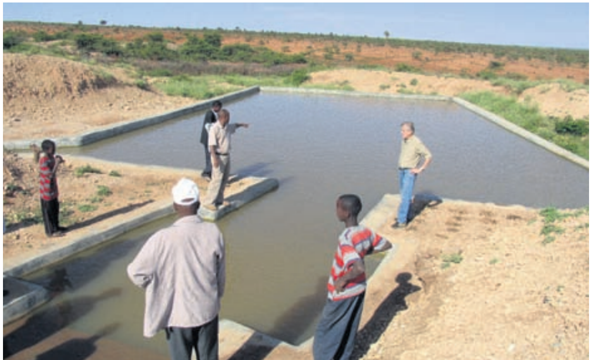
Rigningarvatn safnast í þróna og dugir þrjá til fjóra mánuði inn í þurrkatímann. Með sérstökum efnum er hægt að hreinsa vatnið svo það verði drykkjarhæft.
