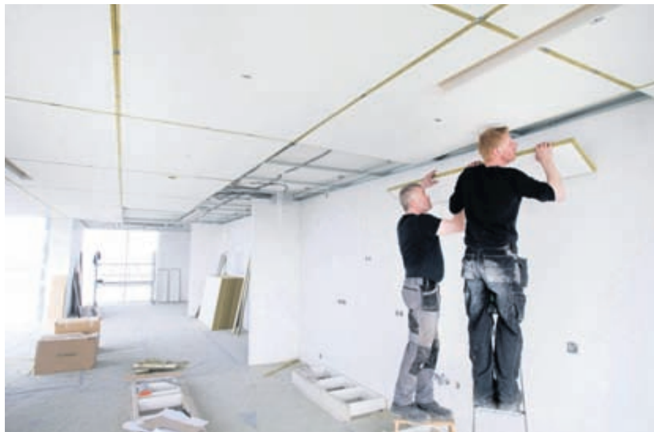
Sérhæfðir starfsmenn Parka við uppsetningu Mono-lofts.
