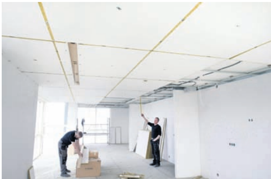
Unnið við uppsetningu Mono-lofts í blokkaribúð í Reykjavík.
