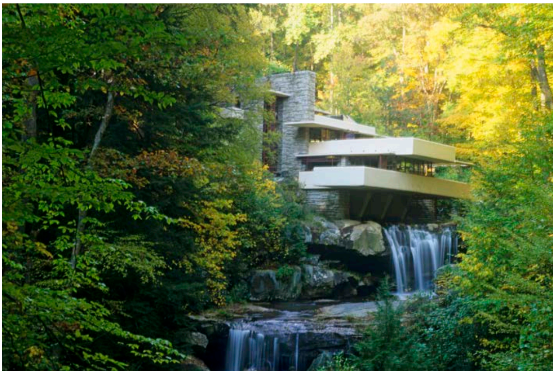
Húsið var valið fallegasta bygging 20. aldarinnar. NORDICPHOTOS/GETTY
