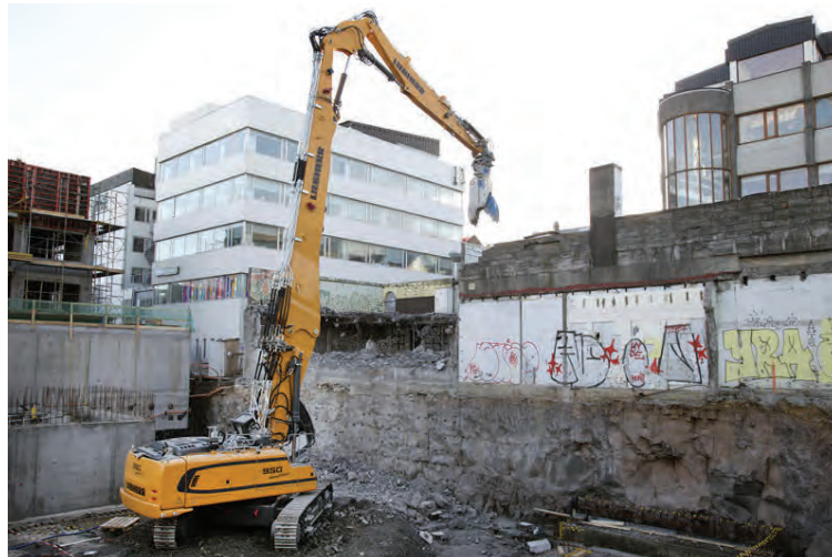
Liebherr R950 Demolition er sérhæfð niðurrifsvél. MYND/STEFÁN
