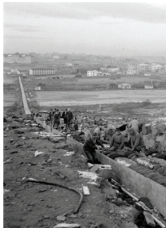
Myndin er tekin til norðurs frá Öskjuhlíð um 1940. Fremst er unnið við einangrun á rörum í hitaveitustokki með reiðingi. Fjær má sjá Hlíðarenda, íþróttasvæði Vals. MYND/ORKUVEITA REYKJAVÍKUR
