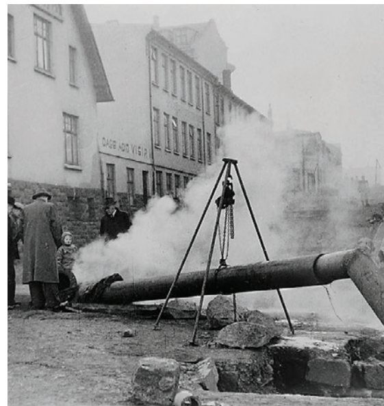
Viðgerð á hitavatnslögn á gatnamótum Hverfisgötu og Ingólfsstrætis. MYND/ORKUVEITA REYKJAVÍKUR
