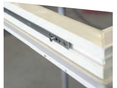
Lausafögin eru einstaklega vönduð og þétt með yfirfellanlegum kanti.
