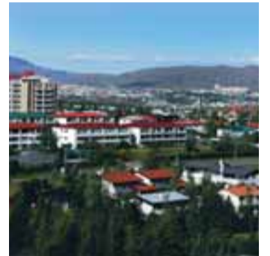
ÍBÚÐIR Í REYKJAVÍK Svo virðist sem bankarnir búi sig undir verulega verðlækkun íbúðarhúsnæðis. Það endurspeglast meðal annars í lækkandi veðhlutfalli íbúðalána. MARKAÐURINN/STEFAN
