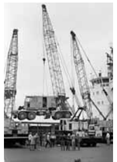
Hópur manna fylgdist með þegar stærsti krani sem fluttur hafði verið til landsins er hífður í land í Sundahöfn 25. maí 1983. Kraninn var 110 tonn.
