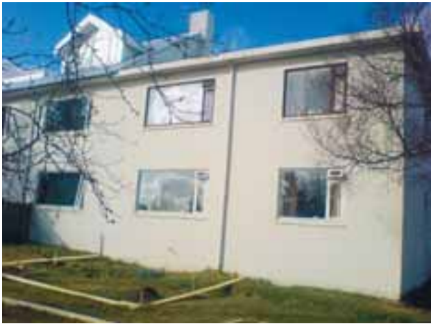
Fyrir breytingar. Garðurinn nýttist illa þar sem ganga þurfti hringinn í kringum húsið til að komast í hann.
