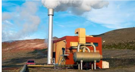
Green Energy Geothermal vinnur að endurnýjun vélbúnaðar í gömlu gufustöðinni í Bjarnarflagi. Framkvæmdir hófust í mars. LJÓSMYND/LANDSVIRKJUN
