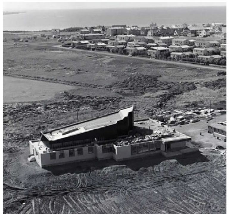
Fimmtíu ára gömul mynd af Norræna húsinu í byggingu. MYND/NORRÆNA HÚSIÐ
