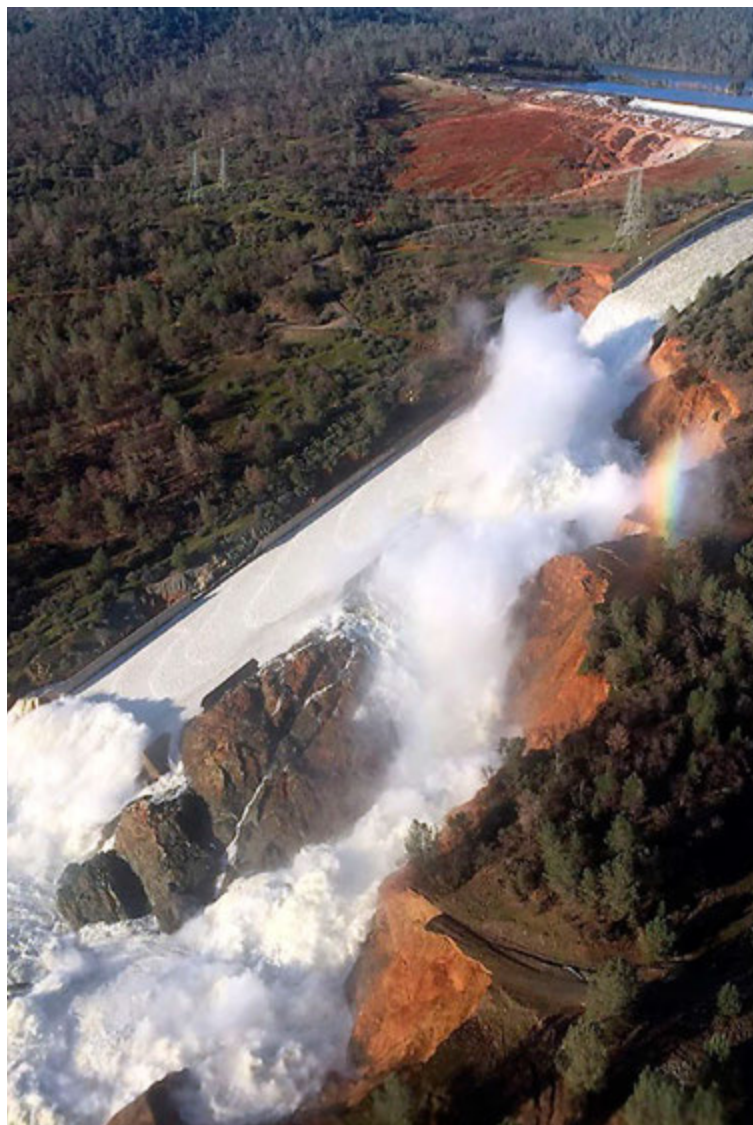
Vatnflaumurinn streymir úr skemmdri yfirfallsrás Oroville-stíflunnar í Kaliforníu.
