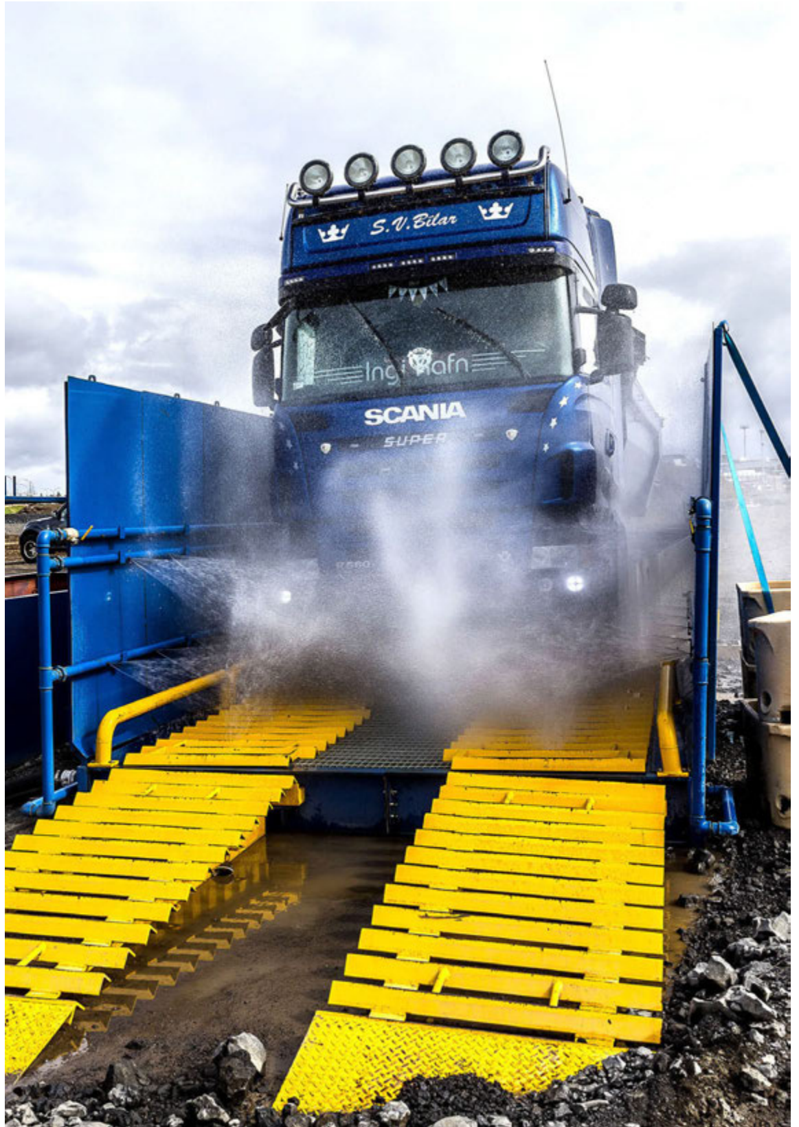
Burt með skitinn Vörubíll í dekkjahreinsivél á byggingarsvæðinu við Hlíðarenda í Reykjavík. „Þetta er komið í reglugerð borgarinnar. Það er allt hreinsað sem fer út af svæðinu, til dæmis dekkinn á bílunum,“ segir Gísli Sveinbjörnsson hjá GT verktökum. Vélin ráði við að hreinsa 30 bíla á klukkustund. FRÉTTABLAÐIÐ/VILHELM
