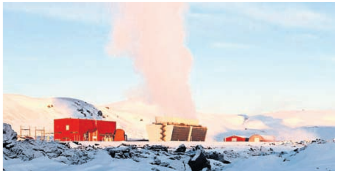
KRÖFLUVIRKJUN Alls hefur Landsvirkjun 20 vatnsafls- og jarðvarmakosti til athugunar.
