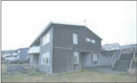
Suðurholt - Sérhæð - Hf. Hraunhamar kynnir Fallega talsvert ENDURNYJADA 125 fm NEDRI SERHÆÐ í góðu tvíbýli á sérlega góðum stað í jarðri byggðar. 3 rúmgóð svefnherbergi. Stutt í alla þjónustu, skóla, leikskóla og gólfvöllinn. Laust strax. Verð 27,9 millj
