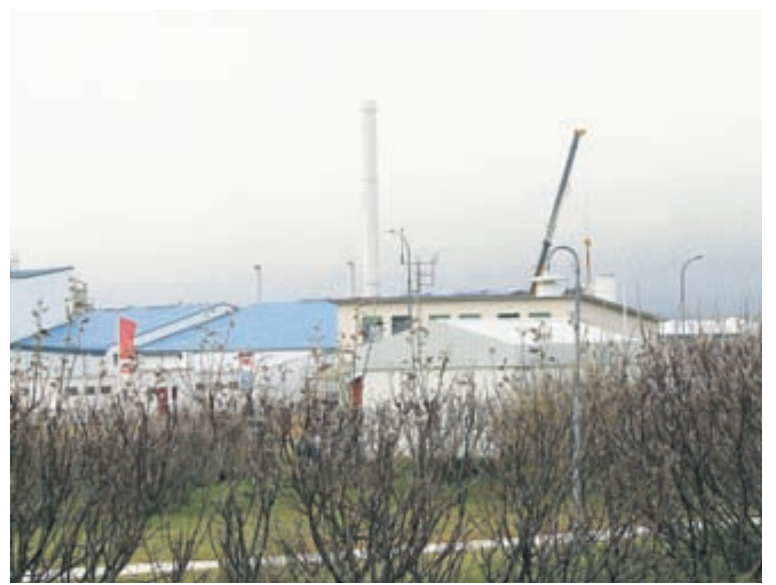
NÝR SKORSTEINN Annar af tveimur reyksháfum sem eiga að vera á fiskimjölsverksmiðju Ísfélagsins á Þórshöfn hefur verið reistur. MYND/GUNNÓLFUR LÁRUSSON
