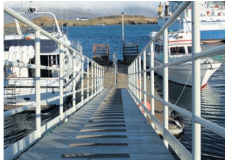
Snarbrattur rampur við flotbryggjuna hjá Viðeyjarferjunni er torveldur yfirferðar.
