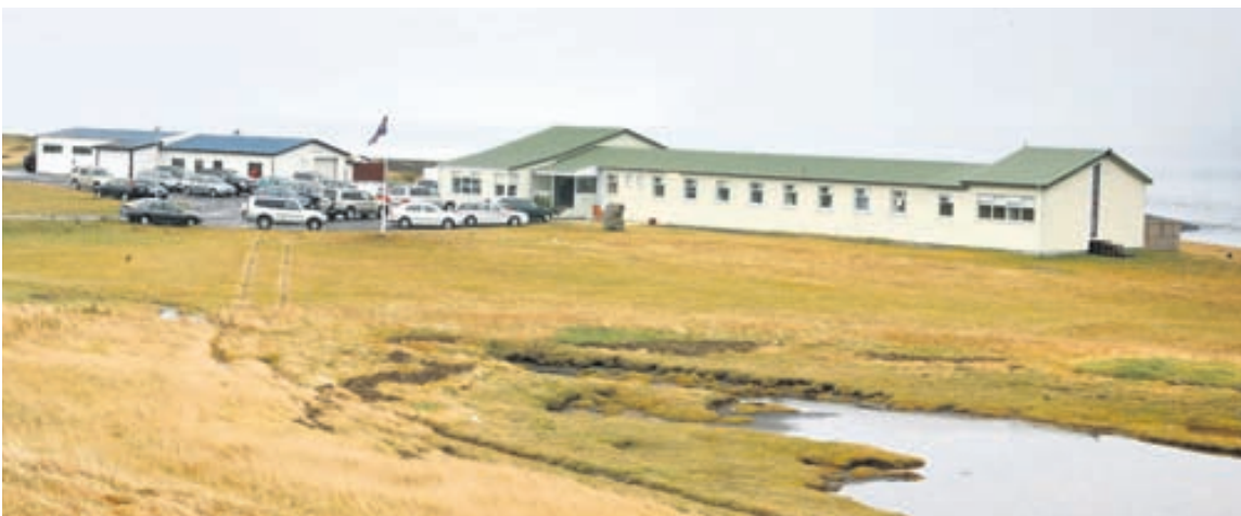
KVÍABRYGGJA Í ljós hefur komið að fangar á Kvíabryggju voru með sjó farartæki af ýmsum toga.
