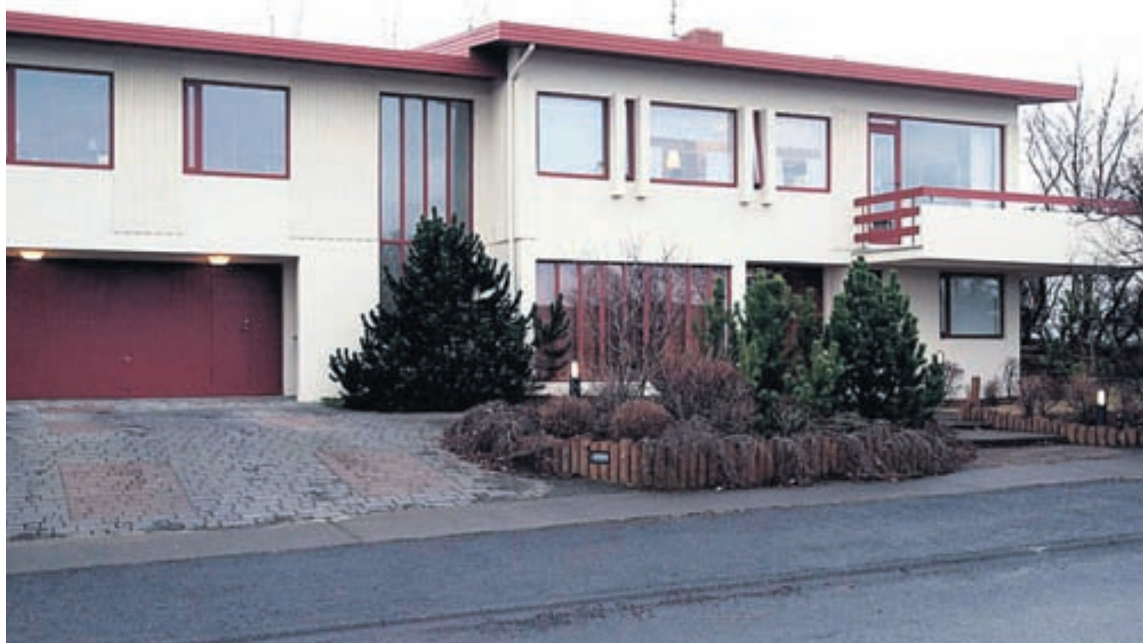
Húsið er á tveimur hæðum og alls 292,9 fermetrar.
