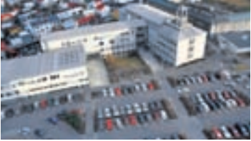
VIÐ IÐNSKÓLANN Hætt var við að sprengja bílakjallara.
