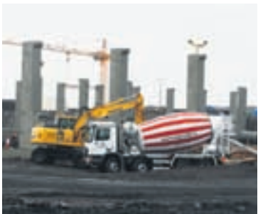
Vegna efnahagserfiðleika var ákveðið að skipta verkinu í tvo áfanga. Unnið er að þeim fyrri um þessar mundir.
