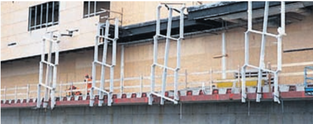
Verið er að reisa stálbita sem þekja munu norðurhlið hússins.
