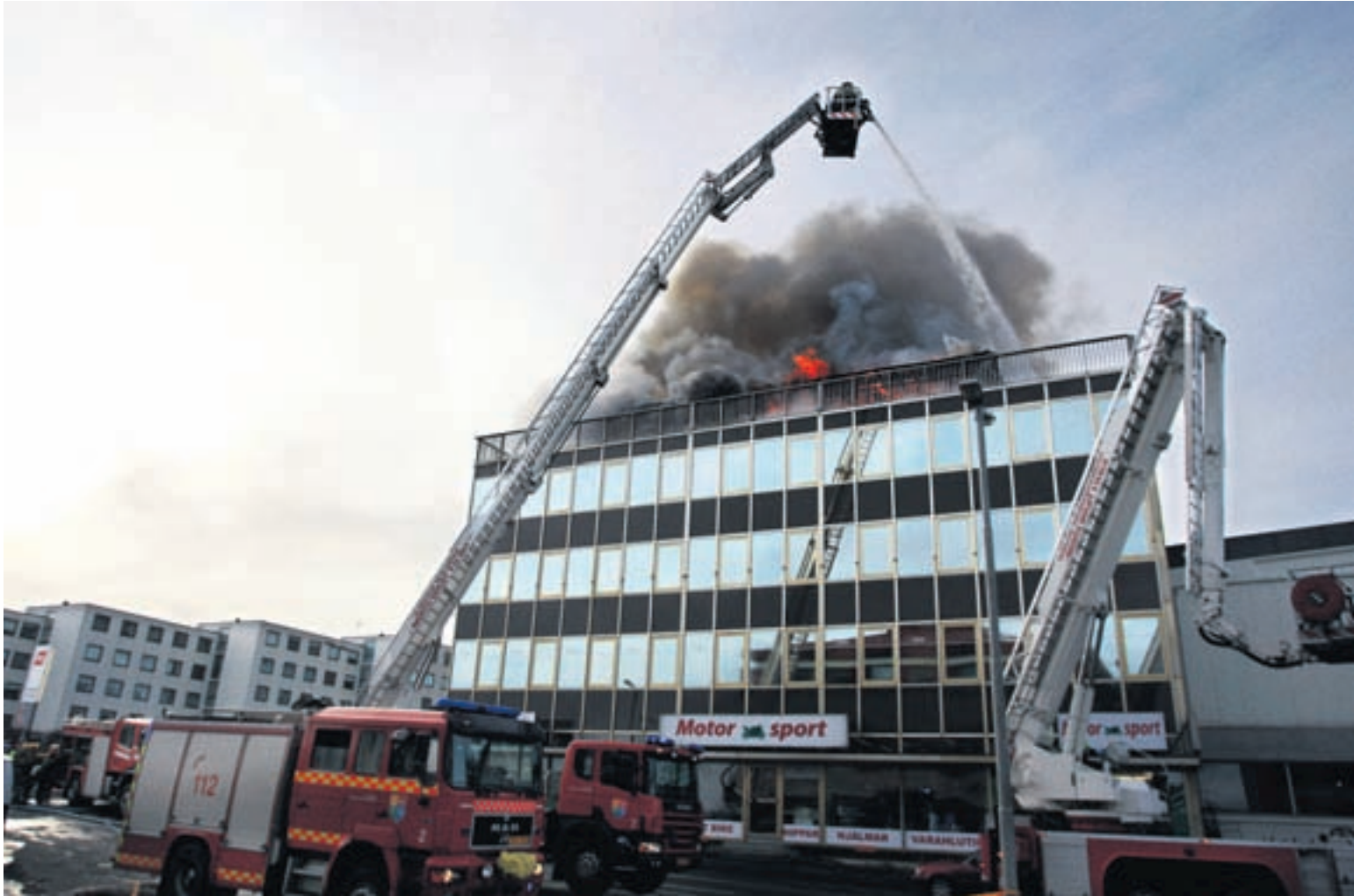
STÓRBRUNI Í SÍÐUMÚLA Mikil hætta skapaðist í gassprengingum í húsi við Síðumúla 34 í gær þegar gríðarlegur eldur braust þar út á örskammri stundu. Um 30 manns voru í húsinu og 70 komu að slökkvistörfum. Húsið er stórskemmt; þakíbuð gjöreyðilagðist og reyk- og vatnsskemmdir eru á neðri hæðum. Litlu munaði að handrit íslenskra tónskálda færu fyrir lítið, en þau eru geymd í húsnæði á þriðju hæð. Sjá síðu 4
