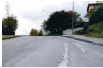
HÁBRAUT Í KÓPAVOGI Íbúar við Hábraut segja þessa steypu eftir steypubíla Borgar, sem fari sífellt bratta brekkuna, þrátt fyrir að það leki úr bílunum.
