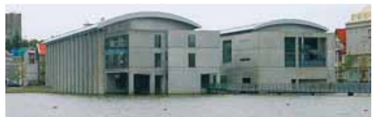
RÁÐHÚS REYKJAVÍKUR Dregið verður úr framkvæmdum en leitast við að halda grunnþjónustu óbreyttri samkvæmt fjárhagsáætlun sem lögð verður fram í næstu viku.
