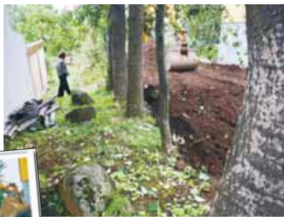
LÓÐAMÖRKIN Framkvæmdir við bílskúr í Fífuhvammum 25 ögnuðu stórum öspum nágrannanna.
