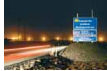
REYKJANESBRAUT Framkvæmdir við tvöföldun Reykjanesbrautar hafa legið niðri í nokkurn tíma vegna fjárhagsöruggleika verktaka.
