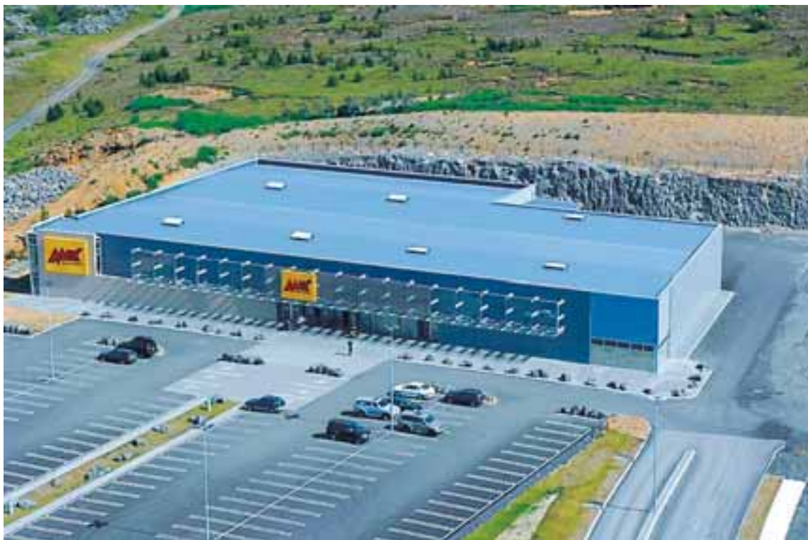
Verslunin MAX í Garðabæ er stálgrindarhús sem Bakkafell og Virkjun reistu í sameiningu.
