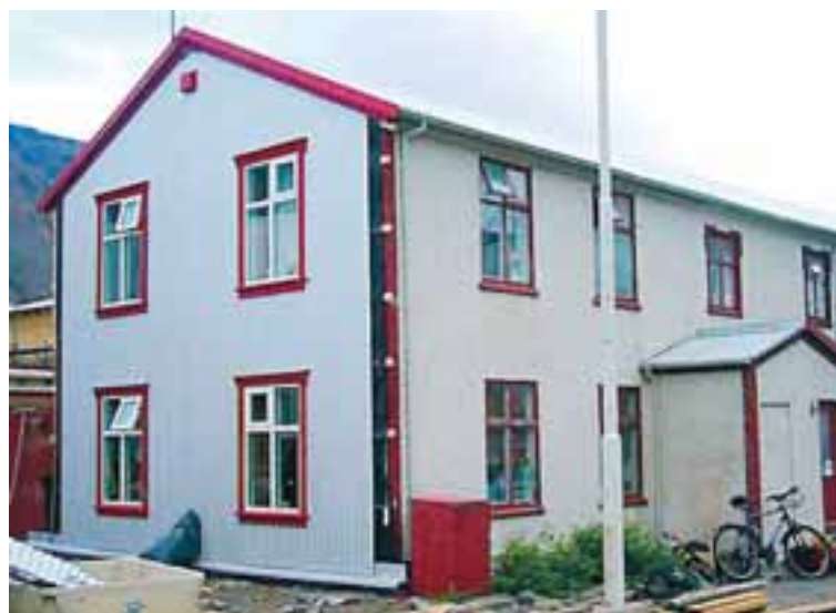
Húsið er forskalað og svona leit það út í júní síðastliðnum þegar búið var að klæða stafninn.
