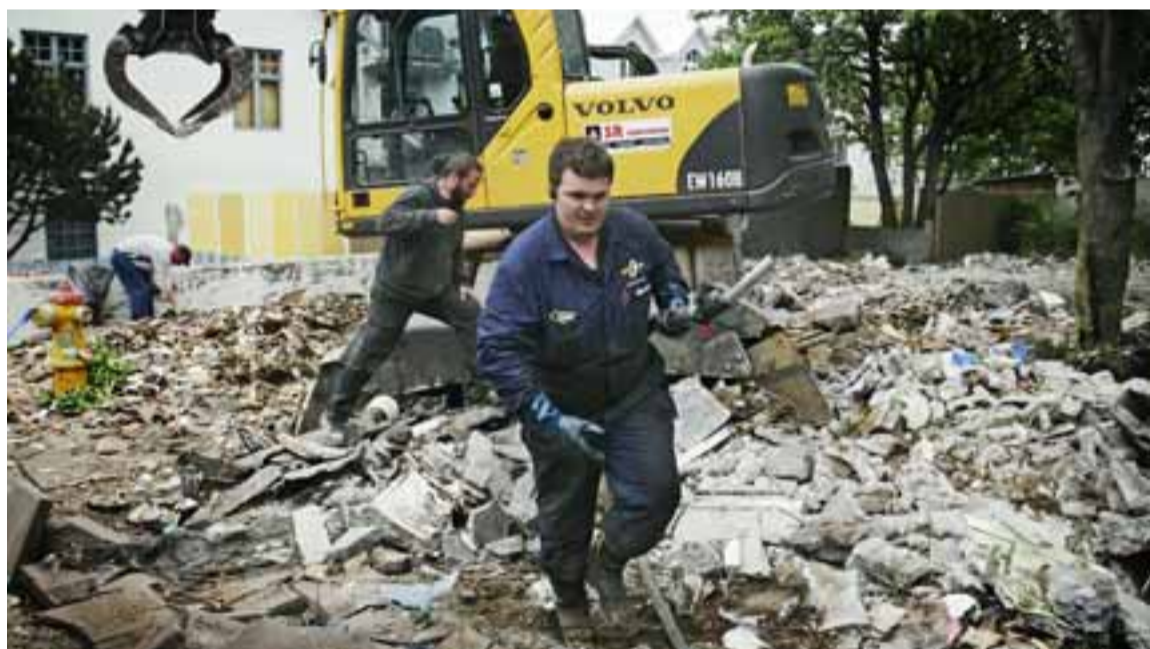
RÚSTIR EINAR Máltækið segir að allt sé breytingum háð og það verða Reykvikingar sem aðrir áþreifanlega varir við þessa dagana. Þessir vösku sveinar létu til sín taka á Frakkastígnum í gær við að rýma fyrir framtíðinni. Gröfukjarturinn hefur lokið verki sínu en mannhöndin sér um að sópa upp. Fyrr en varir mun ný og glæsileg bygging skryða þennan reit. FRÉTTABLAÐIÐ/HÖRÐUR
