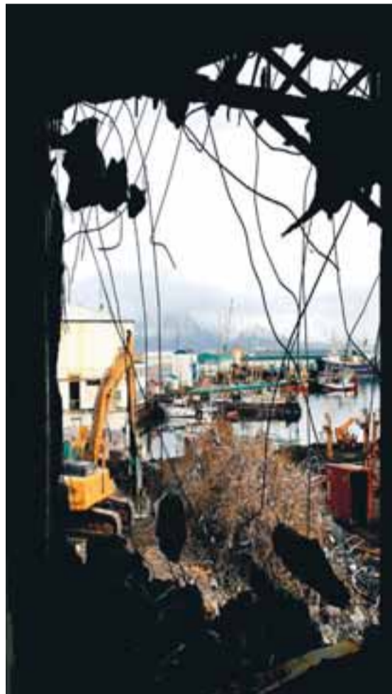
NIÐURRIF Þegar asbestklæðning er rifin þylast upp asbestryki sem er hættulegt mönnum. Alvarlegir sjúkdómar, eins og lungnakrabbamein, geta komið í ljós áratugum síðar. MYNDIN TENGIST EKKI EFNI FRÉTTARINNAR MED BEINUM HÆTTI.
