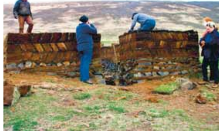
Veggurinn sitt hvoru megin við innganginn var hlaðinn upp og bætt ofan á hina veggina. MYND/SIGRÍÐUR SIGURDARDÓTTIR
