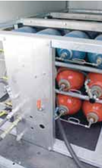
Sprautuklefinn er knúinn íslensku metani sem til fellur við sorpurðun. Hann er því mun umhverfissvænni en margir aðrir klefar.
