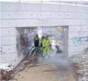
VIÐ JÓNSGEISLA Háþrýstidæla með vatni yfir suðumörkum á að eyða veggjakroti. MYND/FRAMKV/EMDASVIÐ REYKJAVÍKUR gerð tilraun með þann búnað fljótlega.“ - gar
