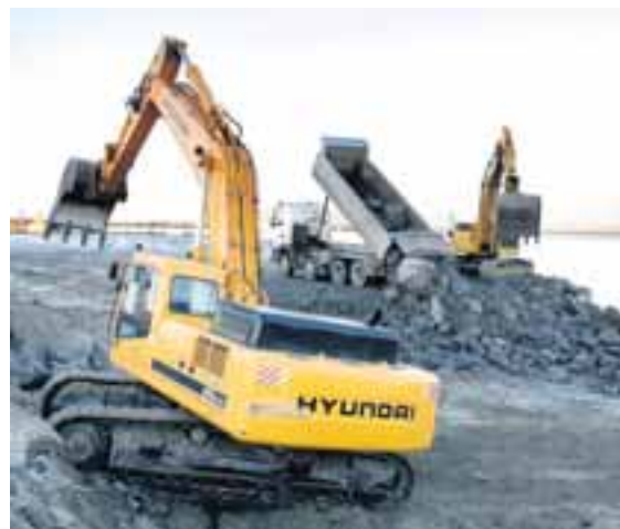
Þrjátíu og fjögurra tonna Komatsu-grafa og fjörutíu og fimm tonna Hyundai-grafa jafna úr hlössunum sem sturtað er í uppfyllinguna.
