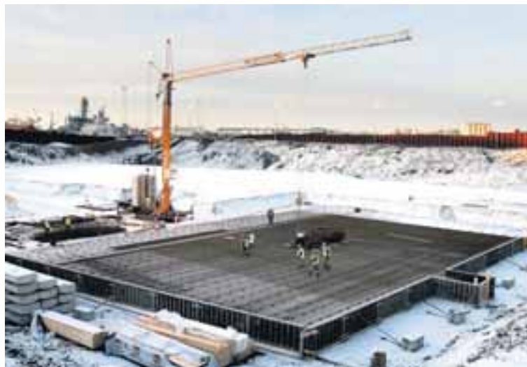
Járnin eru þétt bundin í grunninum og krani kemur að góðum notum við að færa til þungavörna.
