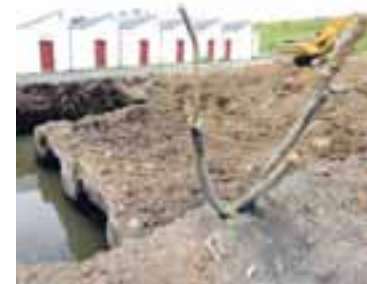
GRUNNURINN BÍÐUR Grunnurinn undir nýju öryggisrannsóknarstofuna er tilbúinn.
