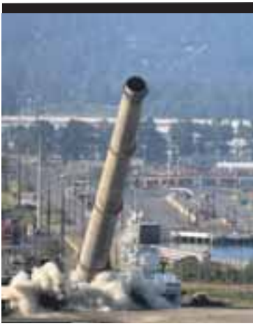
REYKHÁFUR HRYNUR Þessi reykháfur í Tacoma í Washington, Bandaríkjunum, var sprengdur niður um helgina. Reykháfurinn var í eigu Kaiser álfyrirtækisins, sem hefur lokað verksmiðjum sínum þar í bæ. Reykháfurinn var 150 metra há, eða um það bil helmingi hærrí en Hallgrímskirkja í Reykjavík.
