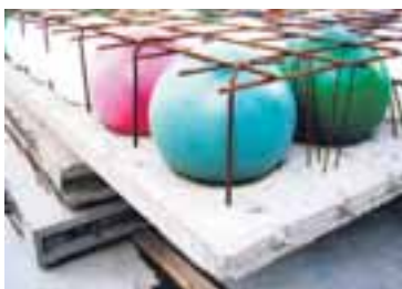
Hér sést bygging kúluplatna vel. Steyptur botn og plastkúlur skorðaðar af járngrind. MYND: HAUKUR EIRIKSSON
