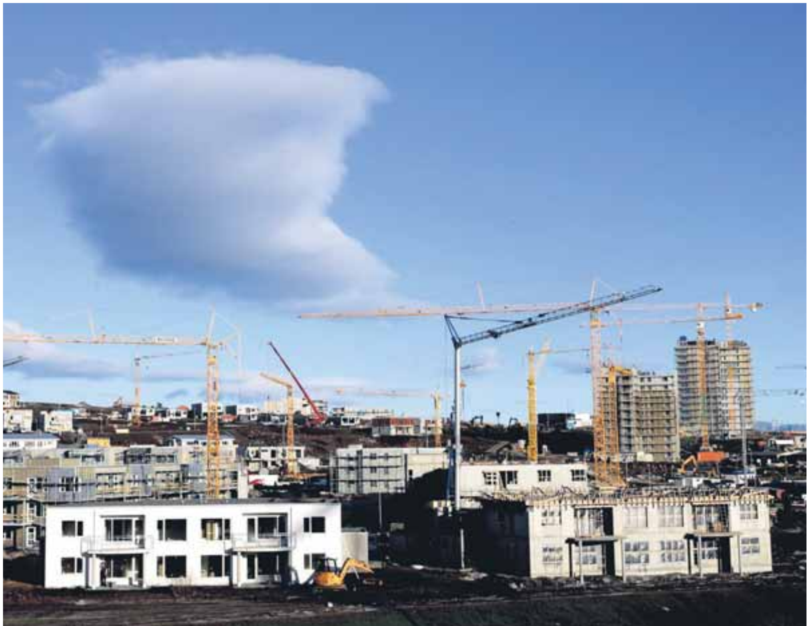
Gular vinnuvélar og háir krannar prýða Kórahverfið sem er í hraðri uppbyggingu.
