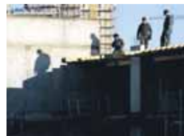
Það er unnið og unnið.
