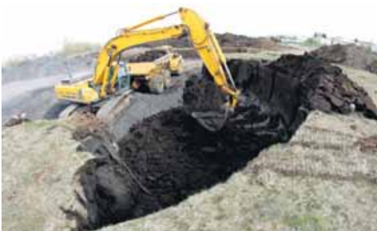
BYRJAD AÐ BYGGJA Á NÆSTA ÁRI Framkvæmdir vegna 300 íbúða hefjast á næsta ári. Gert er ráð fyrir að þeim ljúki um áramótin 2010 og 2011.
