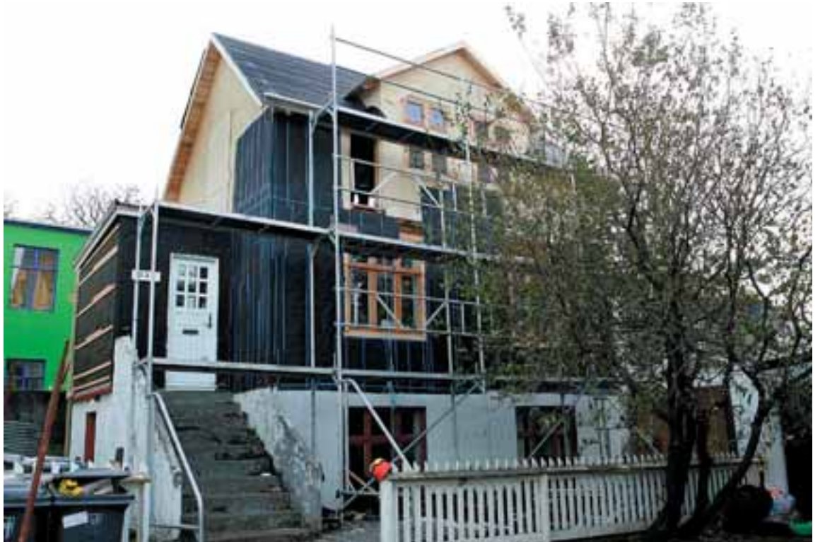
Aukahæðin klæðir húsið vel. Eftir breytingarnar er húsið 135 fermetrar.
