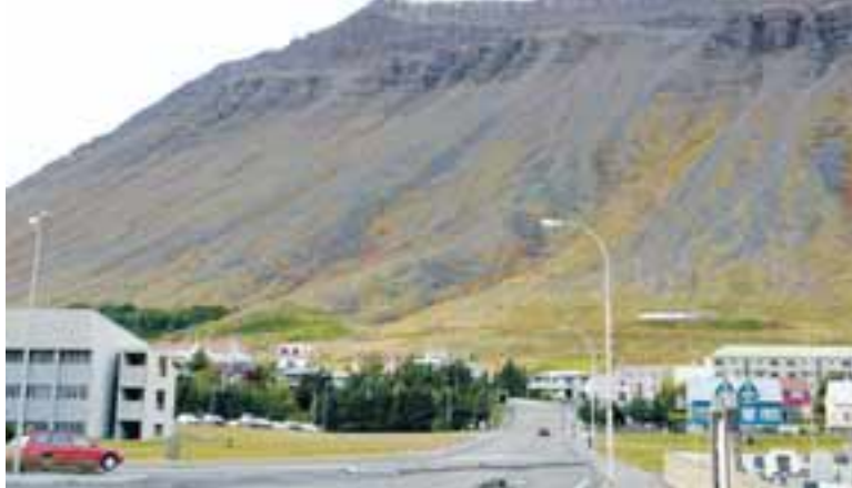
GLEIÐAHJALLI Sprengja þarf fimmtíu steina í Gleiðahjalla og verða íbúar í efstu götum bæj-arins að halda sig fjarri á meðan.
