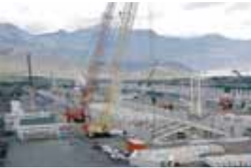
FRAMKVÆMDIR VIÐ KERSKÁLA Byrjað er að reisa burðarvirki skálanna fjögurra.
