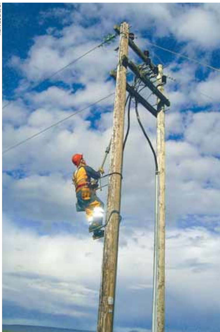
RAFMAGN SBILUN Helgi Viðar Björnsson, starfsmaður RARIK á Kópaskeri, skiptir um öryggi á rafmagnslínu við Keldunes í Kelduhverfi.
