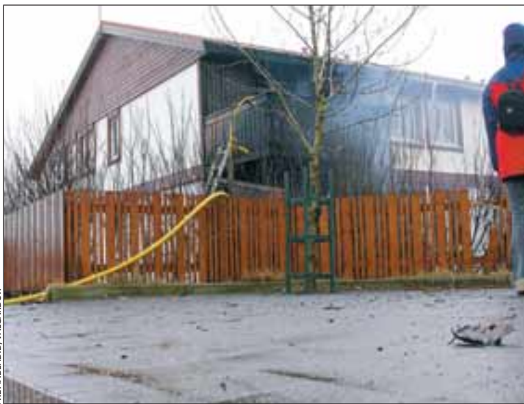
BROTIN ÞEYTTUST Í HÚS OG GARÐA Eldur kom upp í timburhúsi við Rósaríma í gærmorgun. Ekki er ljóst hvert tjónið er en líklegt er að það skipti tugum milljóna króna. Tveir gaskútar sprungu og þeyttust brotin í nærliggjandi hús og garða.
