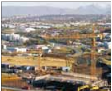
FRAMKVÆMDIR VIÐ REYKJANESBRAUT Brautin verður tvöfölduð í gegnum Kópavog, Garðabæ og Hafnarfjörð á næstu tveimur árum.
