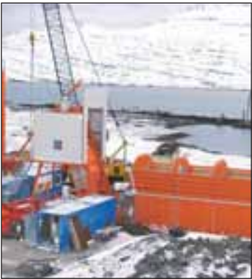
HAFNARFRAMKVÆMDIR Á REYÐARFIRÐI
