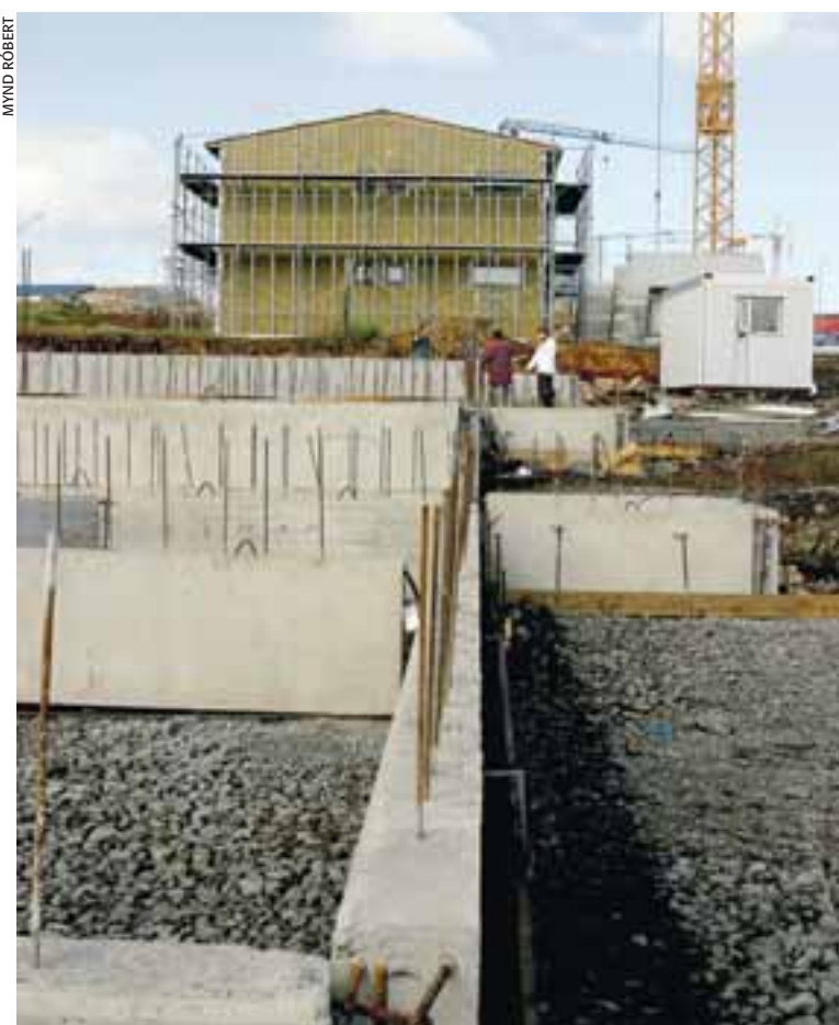
Grunnur risinn að neðra húsinu og það efra komið undir þak. Myndin er tekin 2. júlí 2004.
