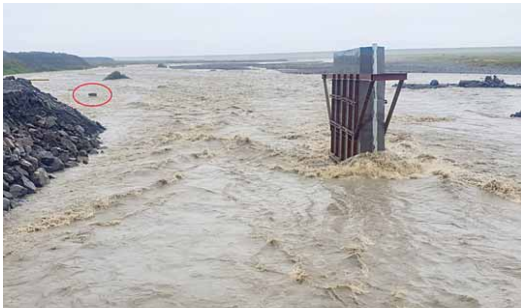
Frá framkvæmdum Vegagerðarinnar við nýja tvíbreiða brú yfir Jökulsá á Sólheimasandi. Rauði hringurinn í vatnslagnum sýnir hvar stofnstrengurinn liggur undir ána. Mynd: RARIK.
